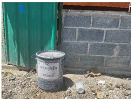
รูปที่ ค-23 จัดให้มีอุปกรณ์ป้องกันการรั่วไหลของน้ำมันและสารเคมีต่างๆ พร้อมทั้งวัสดุดูดซับ
