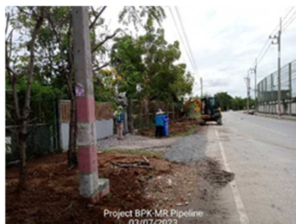
รูปที่ ค-30 ทำทางเบี่ยงชั่วคราว กรณีการวางท่อด้วยวิธีขุดเปิดตัดผ่านทางเข้า-ออกบ้านเรือนชุมชน
