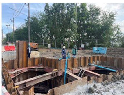
รูปที่ ค-17 ติดตั้งเครื่องมือหรืออุปกรณ์ป้องกันการถล่มของดิน ในการขุดร่องวางท่อส่งก๊าซธรรมชาติ
