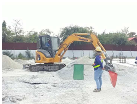
รูปที่ ค-62 กำหนดผู้ทำหน้าที่ขับรถขุด และขุดอย่างระมัดระวังไม่ให้ถูกสิ่งที่อยู่ในแนวขุด
