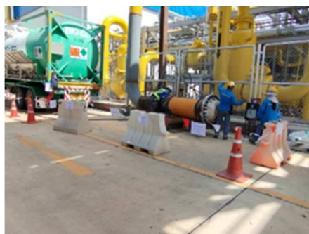
รูปที่ ค-63 กันเขตพื้นที่ก่อสร้าง พร้อมติดป้ายสัญญาณเตือนแสดงเขตหวงห้ามที่อาจเกิดอันตราย
