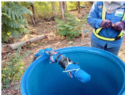
รูปที่ ค-25 ควบคุมอัตราการระบายน้ำออกจากท่อส่งก๊าซธรรมชาติ ภายหลังการทดสอบการรั่วไหลของท่อด้วยวิธีทางชลสติด
