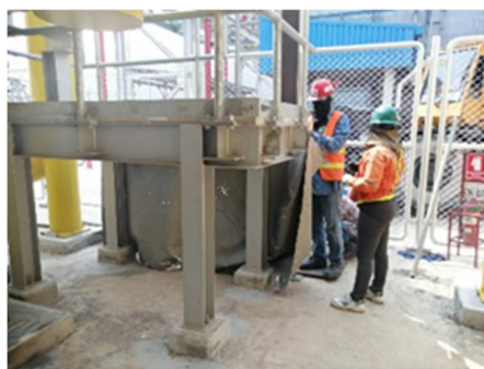
รูปที่ ค-68 จำกัดเขต และระมัดระวังเศษโลหะหรือประกายไฟบริเวณพื้นที่ทำงานเชื่อมท่อ
