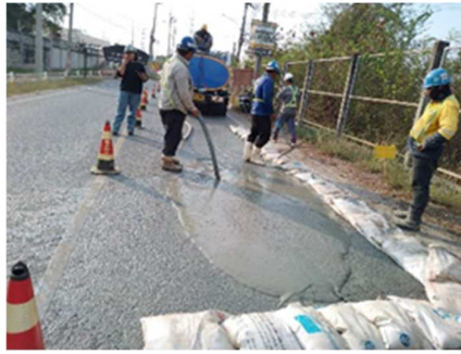
รูปที่ ค-24 จัดวางถุงทรายเพื่อป้องกันโคลนโซเดียมเบนโทไนท์จากการขุดเจาะปนเปื้อนออกสู่แหล่งน้ำพื้นที่ใกล้เคียง
