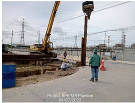
รูปที่ ค-64 ตรวจสอบไม่ให้มีสิ่งกีดขวางหรือผู้ปฏิบัติงานที่อยู่ในระยะที่อาจเกิดอันตรายจากการยกท่อลงร่องขุด
