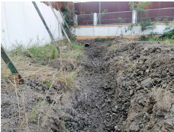
รูปที่ ค-84 ขุดทรายระบายน้ำพร้อมเตรียมเครื่องสูบน้ำสำหรับกรณีเกิดน้ำท่วมขัง
