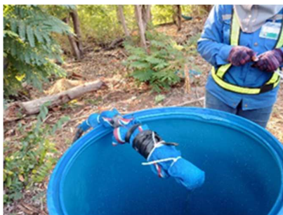
รูปที่ ค-27 ทำการดักตะกอนบริเวณปลายท่อระบายน้ำทิ้ง จากการทดสอบการรั่วไหลของท่อ
