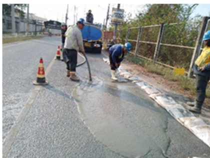
รูปที่ ค-21 โครงการมีการเตรียมรถสำหรับดูดโคลนโซเดียมเบนโทไนท์ กรณีเกิดการรั่วไหล
