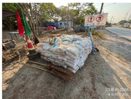
รูปที่ ค-19 โครงการมีการเฝ้าระวังต่อการรั่วไหลของโคลนโซเดียมเบนโทไนท์ ขณะทำการเจาะลอด
