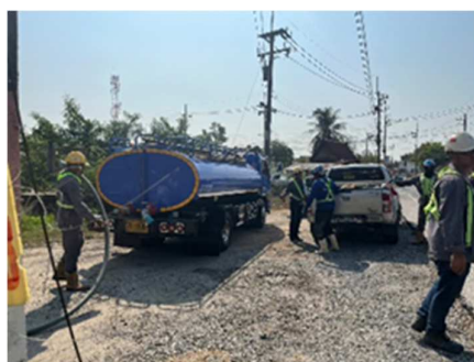
รูปที่ ค-45 ใช้รถดูดในการเก็บเศษดินหรือโคลนโซเดียมเบนโทไนท์ในบ่อรับ-บ่อส่ง
