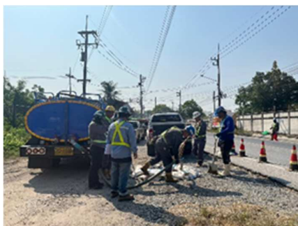
รูปที่ ค-20 โครงการมีการฉีดพ่นลูกฉนวนกรณีโคลนโซเดียมเบนโทไนท์รั่วไหล
