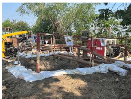
รูปที่ ค-18 โครงการมีการกันพื้นที่โดยการจัดวางถุงทรายขณะมีการก่อสร้างบ่อรับ-ปล่อย
