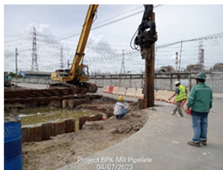
รูปที่ ค-60 มีการควบคุมและมีมาตรการป้องกันดินถล่มที่เกิดจากการขุดเปิดพื้นที่
